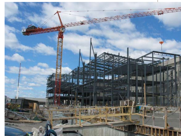
Chantier du complexe intégré de formation en sciences de la santé en juin 2007.
